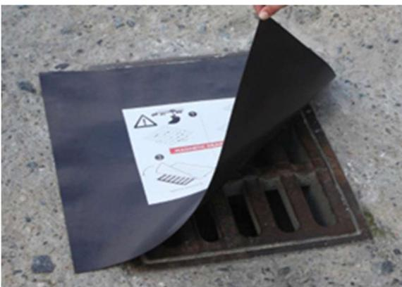
Wenn der Schacht vor dem Umschlag mit einer (magnetischen) Abdeckmatte verschlossen wird, gelangen auslaufende Flüssigkeiten nicht in die Meteorwasserkanalisation.
