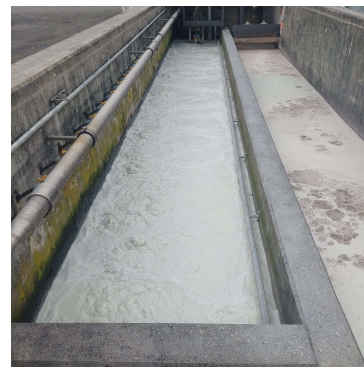
Abwasserstrasse der Kläranlage
