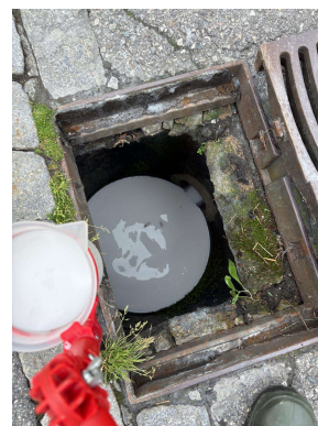
Residui di vernice nella canalizzazione per le acque meteoriche (ricerca dei danni)
