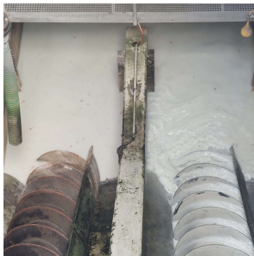
Smaltimento illegale di residui di vernice e intonaco nella canalizzazione delle acque luride dell'impianto di depurazione delle acque
