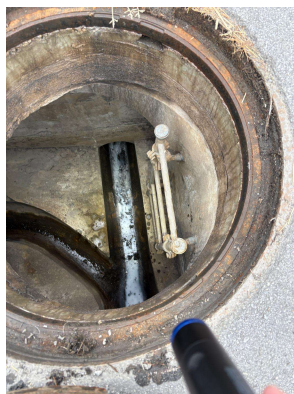
Residui di vernice nella canalizzazione per le acque meteoriche (ricerca dei danni)
