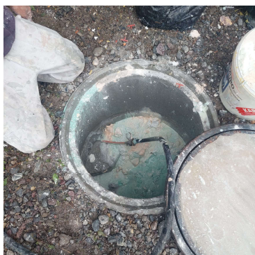
Smaltimento illegale di residui di vernice e intonaco nella canalizzazione delle acque luride dell'impianto di depurazione delle acque
